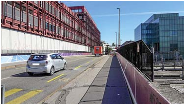
Die Peter Merian-Brücke Richtung Innenstadt gesehen. Die 96 Meter lange und 15 Meter breite Brücke ist zweispurig, inklusive Radstreifen. Sie verfügt über zwei Trottoirs.
