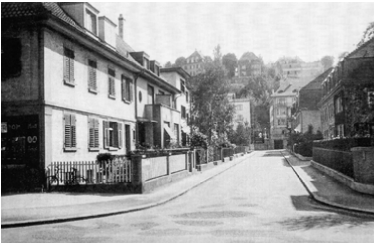
Blick in die Dittingerstrasse um 1938 von der Gundeldingerstrasse her. Auf der rechten Strassenseite ist gut erkennbar, dass die Häuser 10 bis 16 deutlich zur Strasse hin versetzt sind. Somit konnte man die schützenswerte Blutbuche hinter den Häusern erhalten. Im Hintergrund links ist das eben fertig gebaute «Dittingerhaus» erkennbar.
