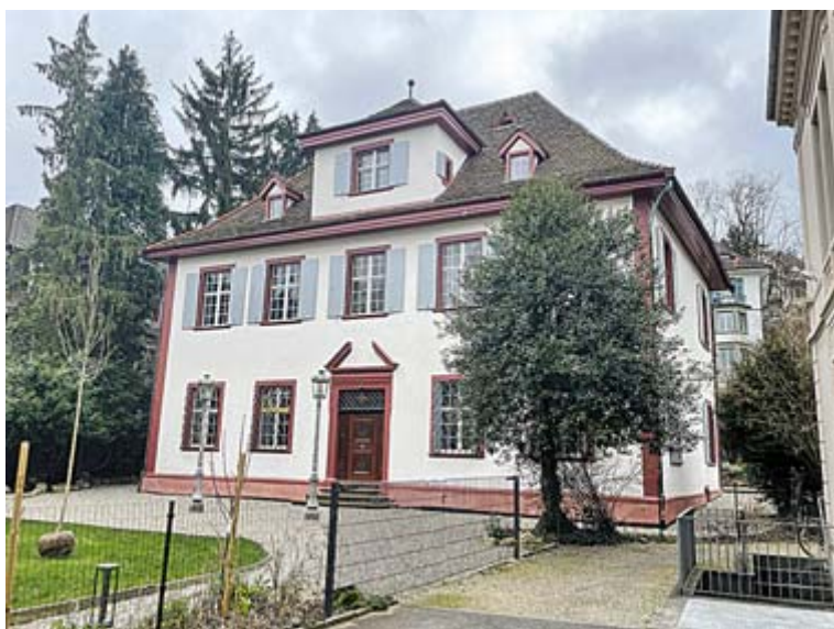
Eines der ältesten noch erhaltenen Gebäude im Gundeli: Dittingerstrasse 20/Gundeldingerstrasse 170. Die Vorderfassade des Schlösschens «Vorderes Gundeldingen». Das «Dittingerschlosschen» wurde 1550 durch Ulrich Iselin erbaut und 1918 verstarb der letzte Gutsherr Friedrich Engel-Gross.
